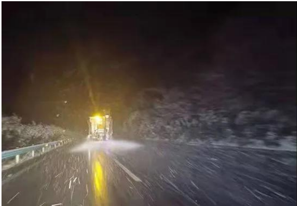
夜间开展融雪除冰作业
